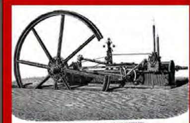
Système d'entraînement et chaudière
