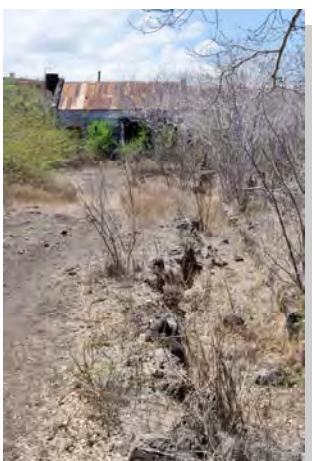
13 Chemin du Moulin Kader à la Station de Pompage
