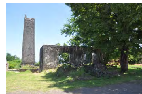
Usine sucrière Desbassayns/De Villèle Saint-Gilles les Hauts
